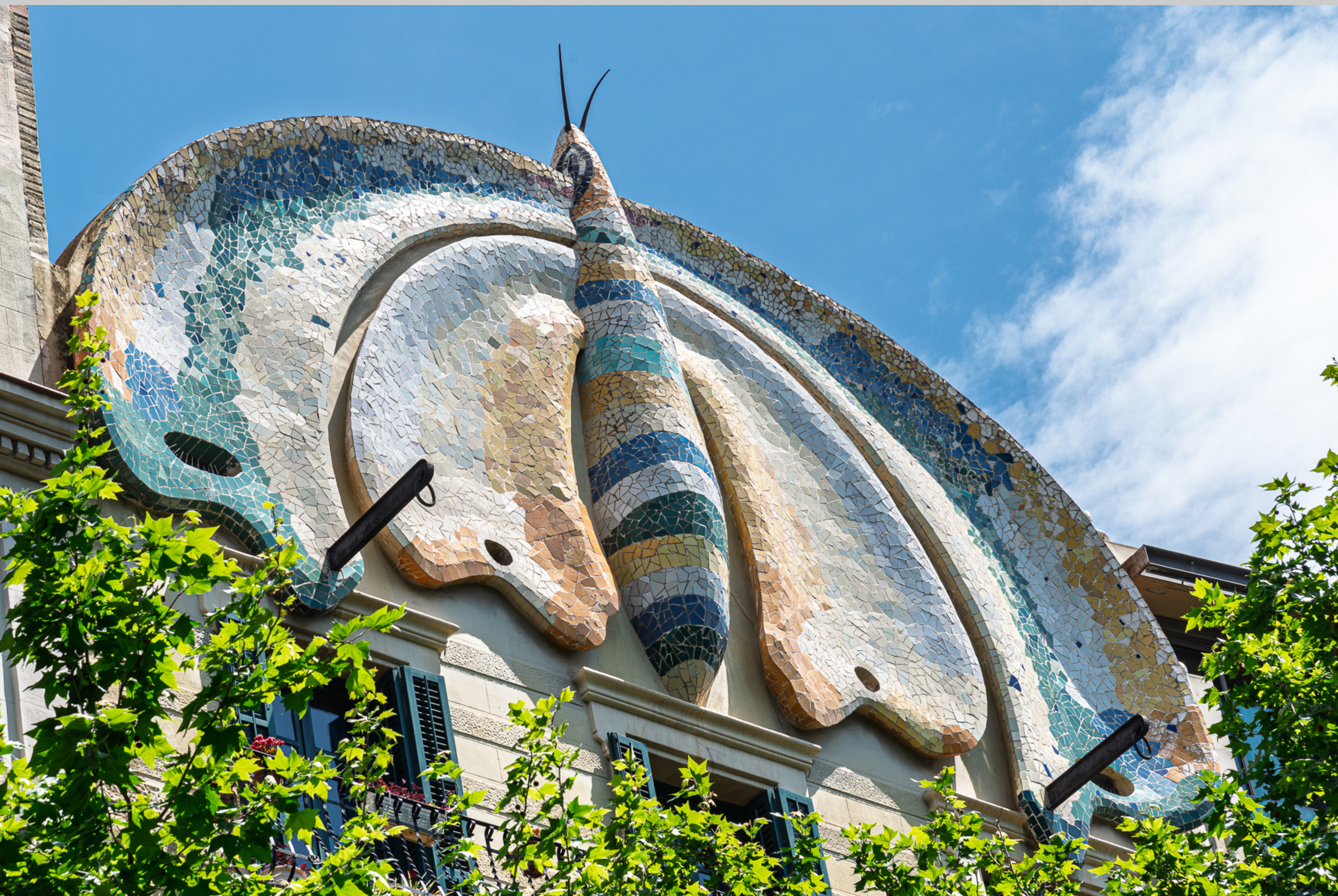
Casa Fajol al carrer Llançà 20 (2021)
